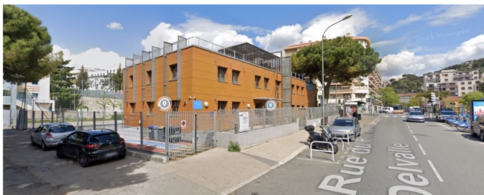
Figure 21 Vue du bâtiment Delvalle
