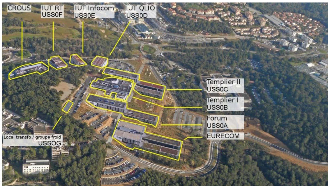
Figure 27 Vue aérienne site SophiaTech (USS)
