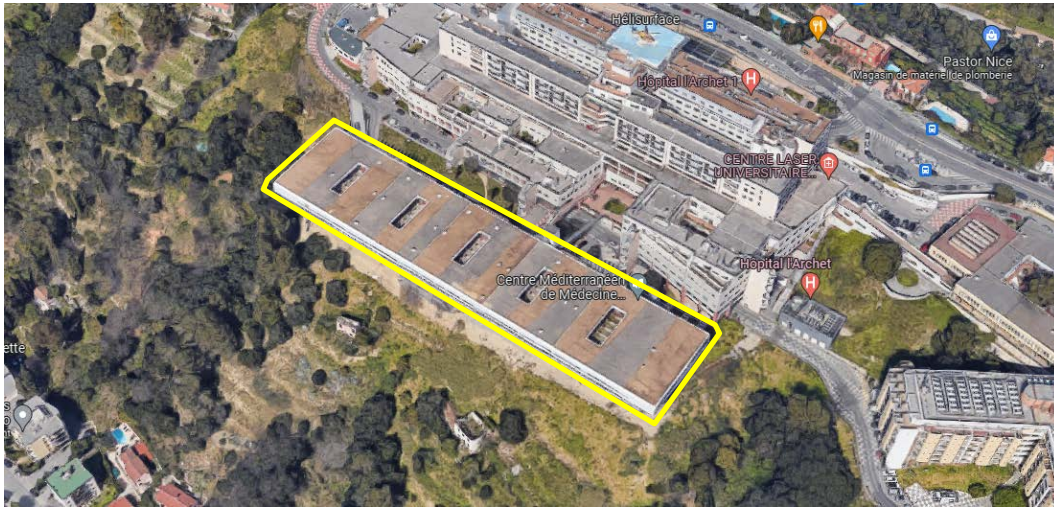
Figure 22 Vue aérienne du bâtiment ARCHIMED, en arrière-plan le CHU L'Archet
