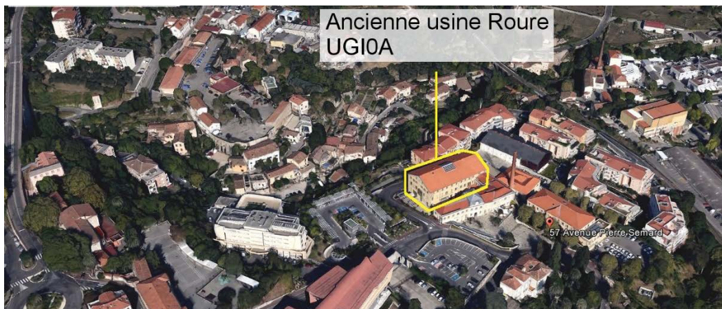
Figure 35 Vue aérienne site de Grasse
