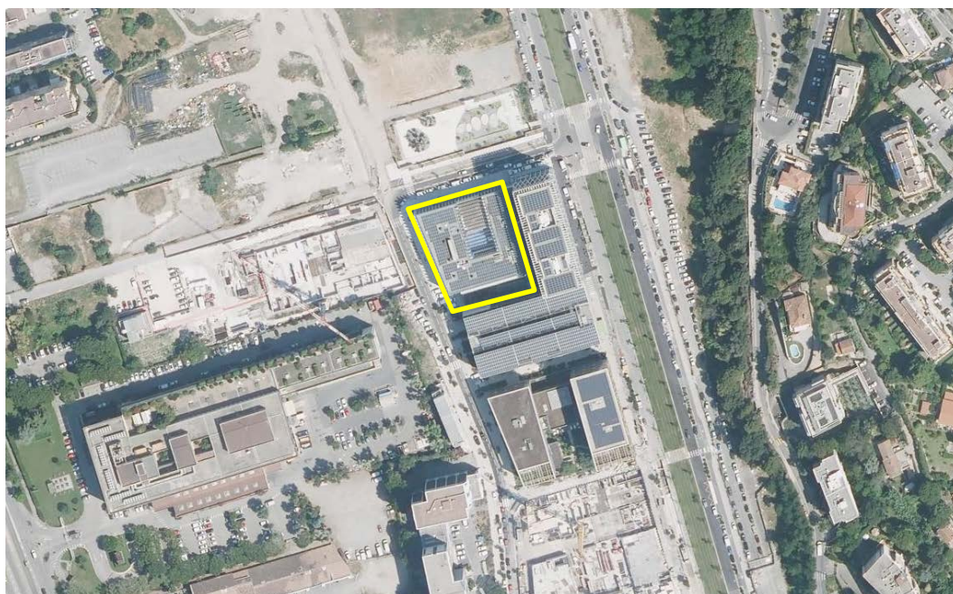
Figure 37 Vue aérienne du site IMREDD achevé
