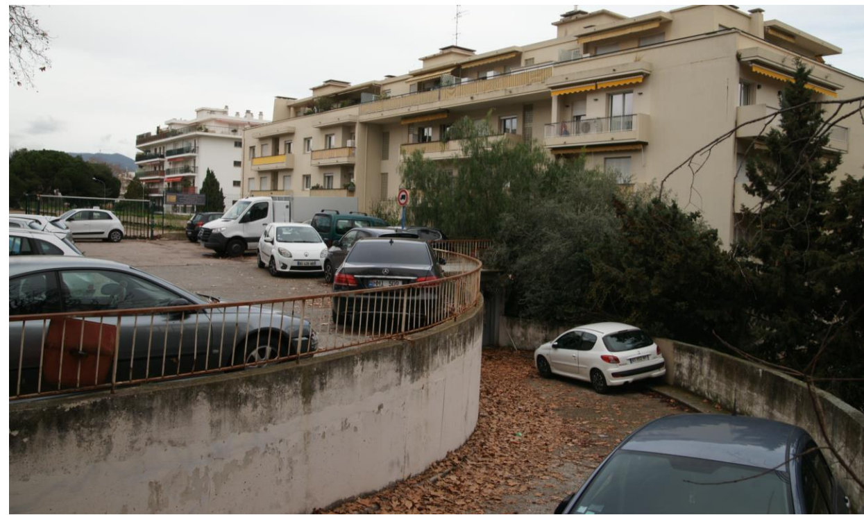
RAMPE VL VERS -1 | COTE OUEST
