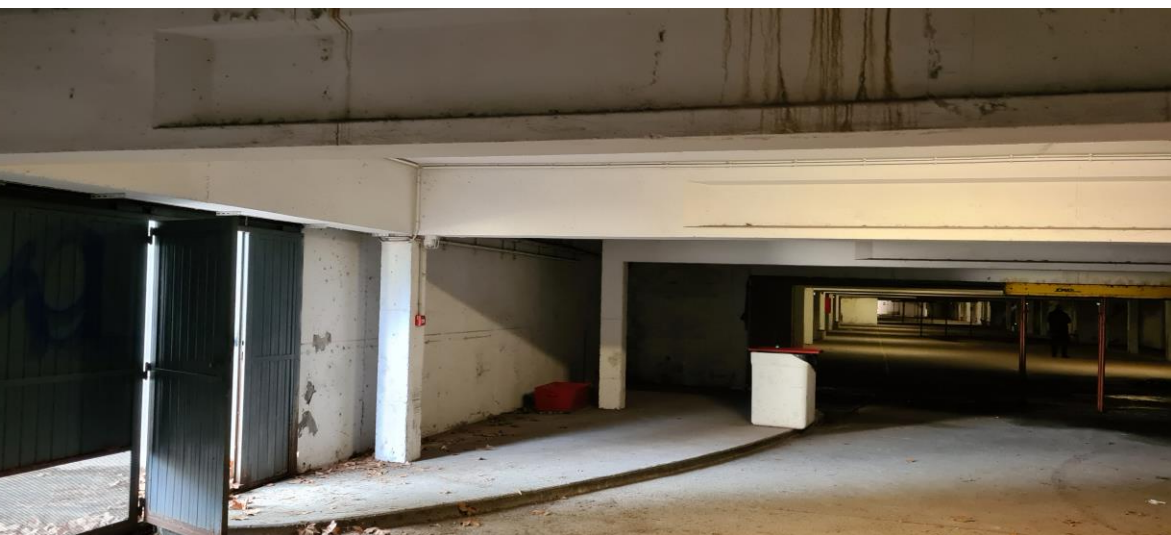
VUES INTÉRIEURES NIVEAU -1
