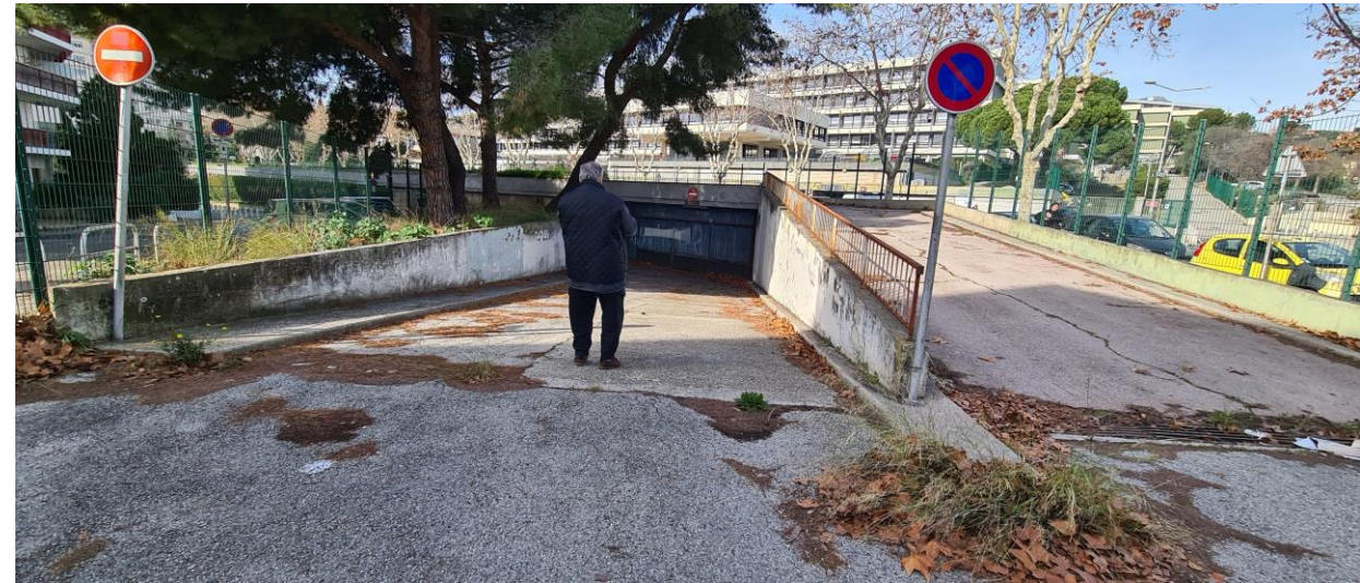
RAMPES VL COTE EST
