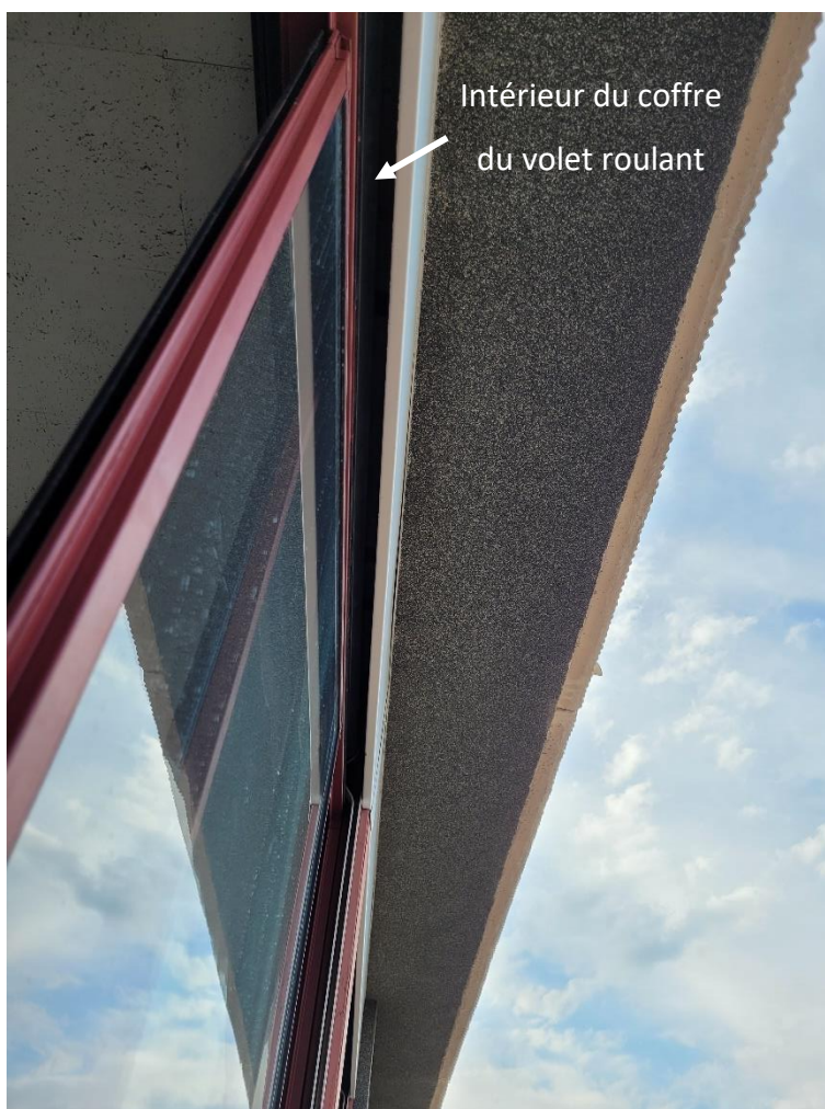
Figure 6 : Localisation de l'espace disponible dans le coffre du volet roulant
