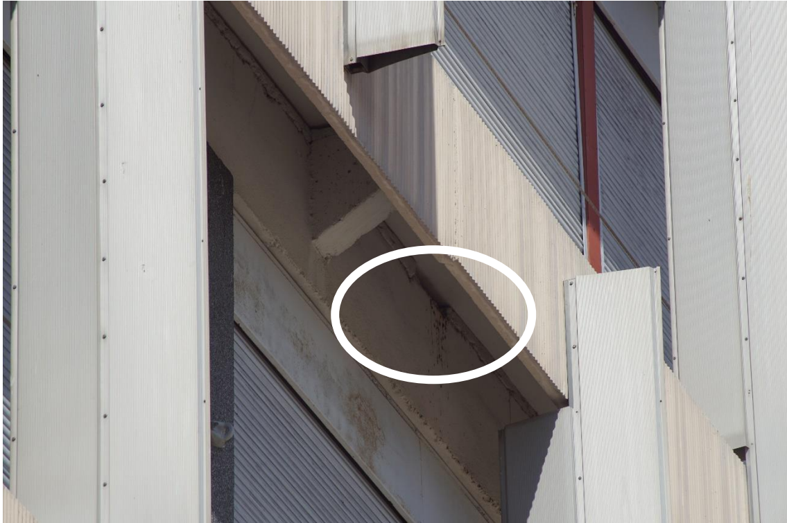
Figure 10 : Espace créé dans le joint pour l'installation d'un nid de martinet
